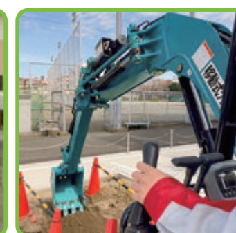
パワーショベルの操作
